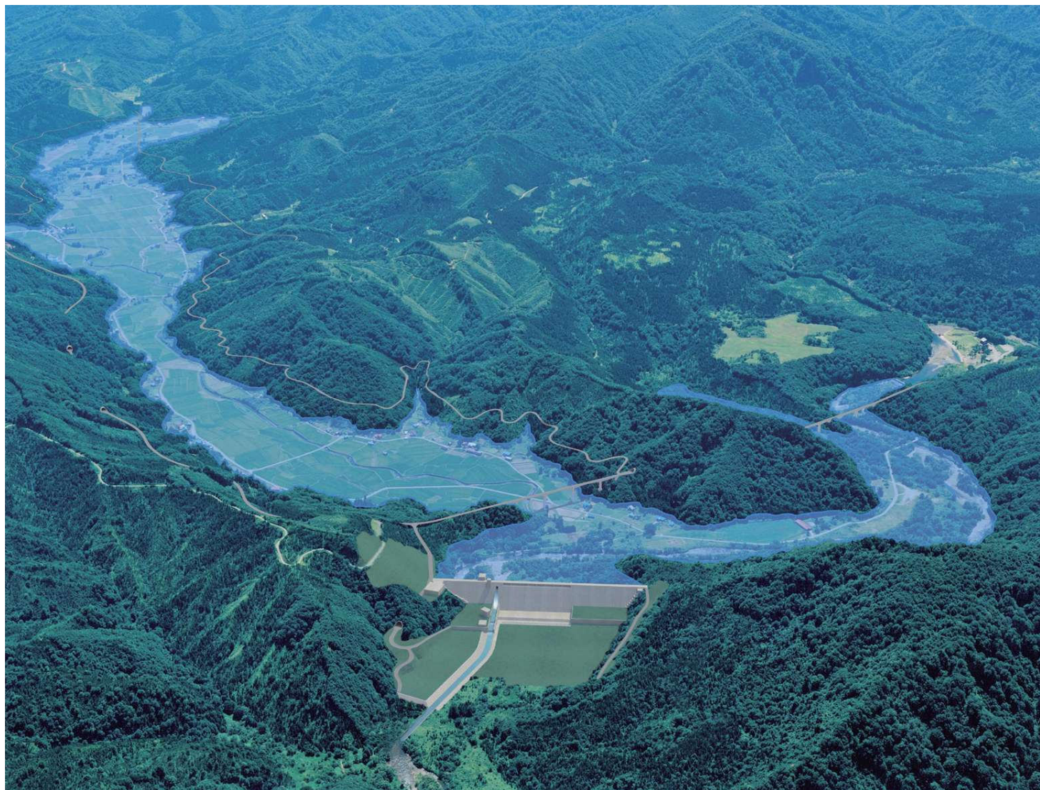
(国土交通省東北地方整備局鳥海ダム工事事務所提供)
